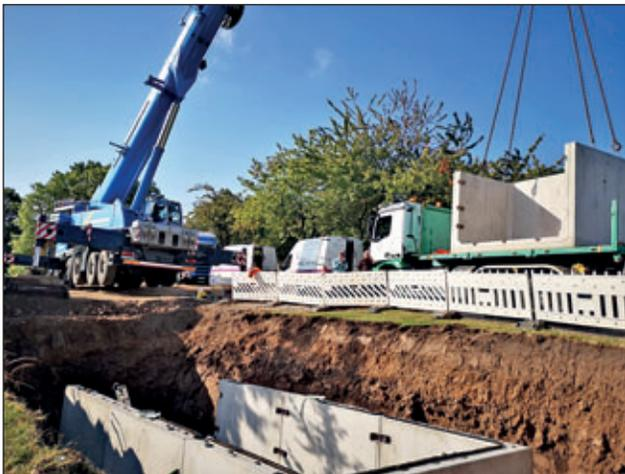
Foto 1 zeigt die Montage der neuem Löschwasserzisterne in Neudörfel mit 5-Achs-Mobilkran, schwerstes Einzelteil ca. 15 Tonnen)
