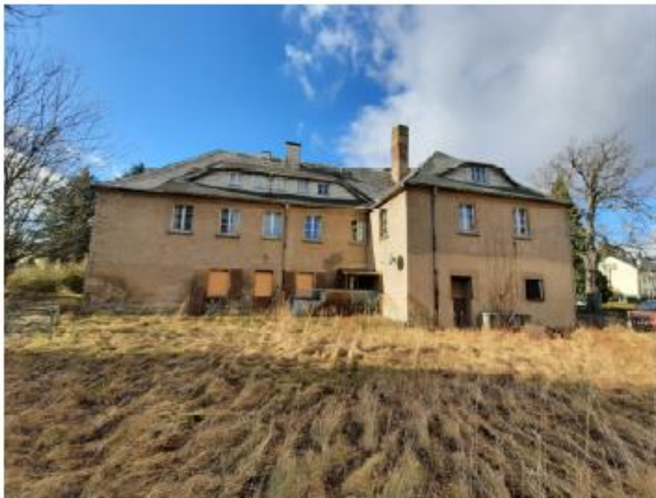
rückwärtige Gesamtansicht - Bettenhaus und Kohlebunker
