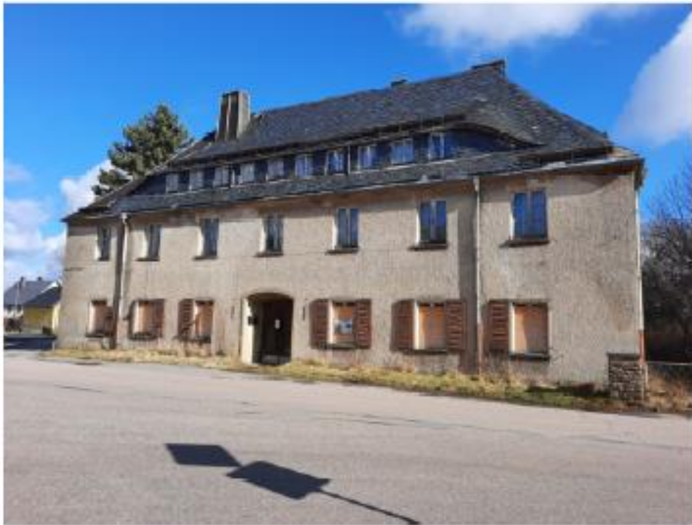
Ansicht des Alten Gasthofes Straßenseite
