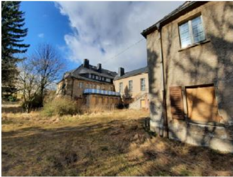
Gesamtansicht mit Bettenhaus (rechts)
